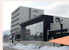
完成が近い全天候型多目的交流空間アトリウム
