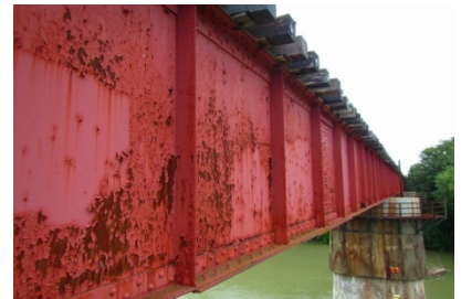
第3空知川橋梁 大正2年完成(経年103年)
