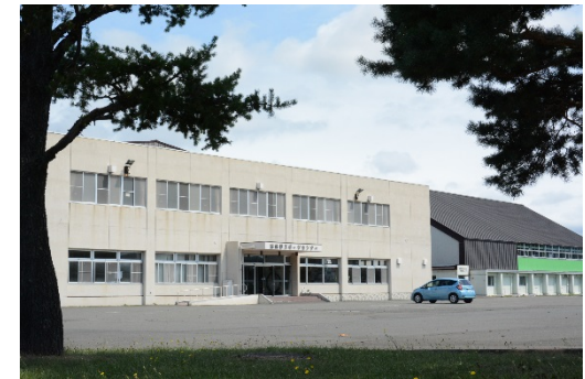
スポーツセンター 昭和49年築
