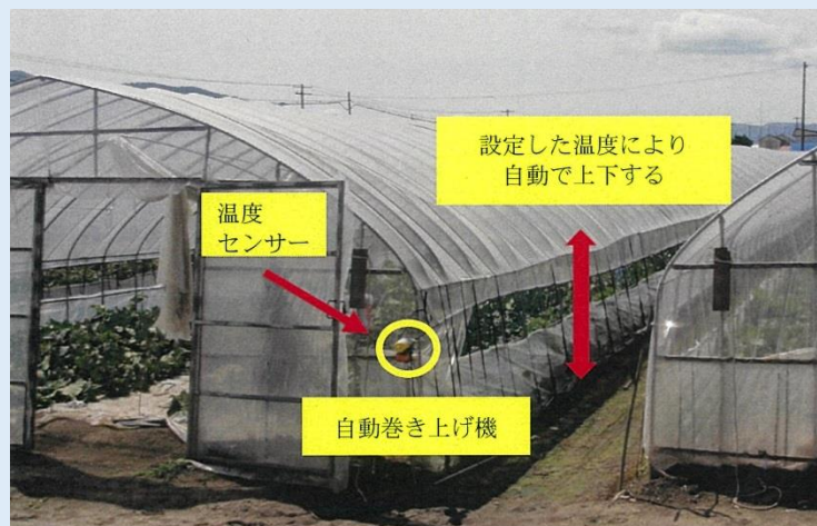
ハウス自動喚起設備
