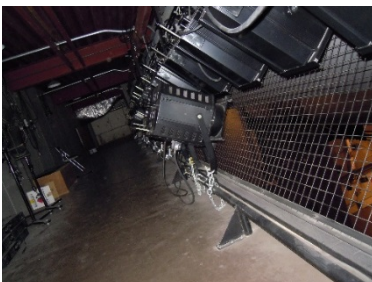
天井裏のキャットウォーク
