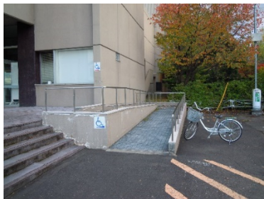
車いす用スロープ
