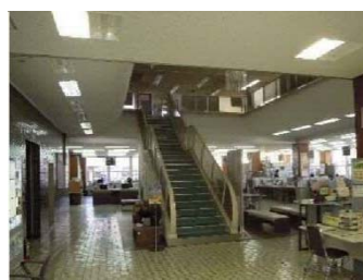
急な階段（エレベーターの設置なし）
