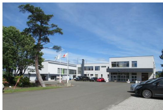
H26年樹海小学校耐震改修
