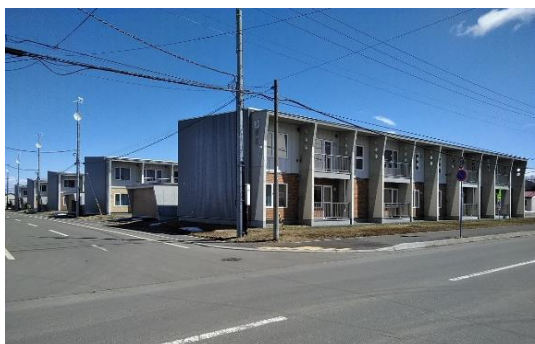
8棟68戸の公営住宅建設
