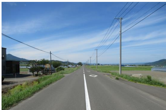
五区山部線外14路線の整備
